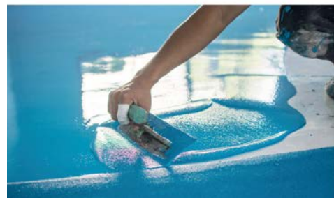
Abb. 7 Chemikalien in Baustoffen können negative Auswirkungen auf die Gesundheit der Verarbeiter haben.
