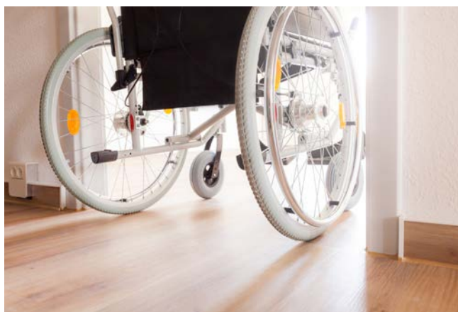
Abb. 8 Ausreichende Durchgangsbreiten, Bewegungsflächen und Vermeidung von Schwellen und Absätzen ermöglichen die Nutzung auch mit Mobilitätshilfen.
